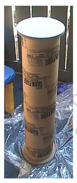
Concrete pour tube cut down from 48 to 40".
